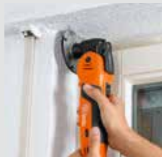
Rolladenkasten-Abdeckungen auftrennen.
