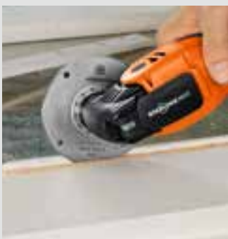
Nägeln an Glasleisten durchtrennen.
