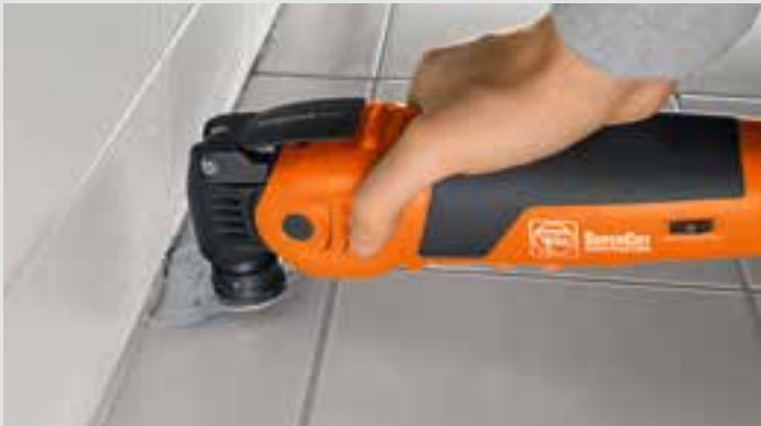
Elastische Fugendichtstoffe entfernen.
