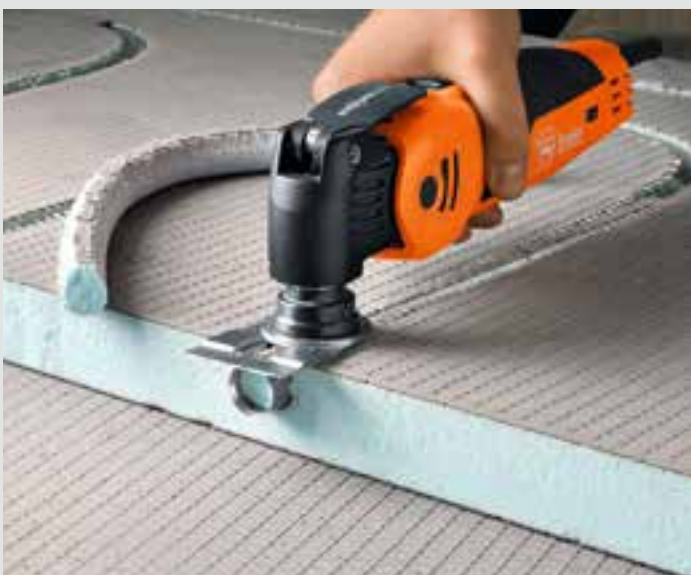
Kanäle für Warmwasser-Fußbodenheizung schneiden.
