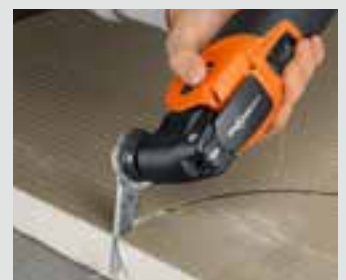
Zuschneiden von Bauplatten.
