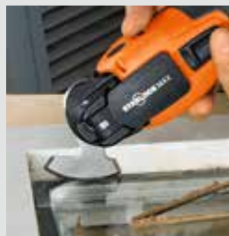
Kittbettverlegte Isolierglasscheiben austrennen.
