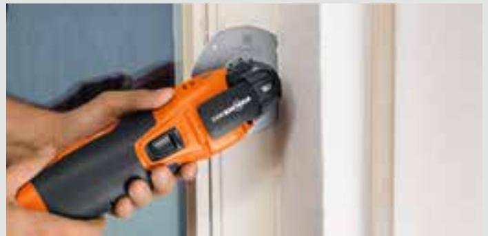
Metall-Befestigungsbänder bei der Altfenster-Demontage durchtrennen.
