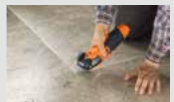
Diamant-Segmentmesser für Schnitte im Eckbereich.
