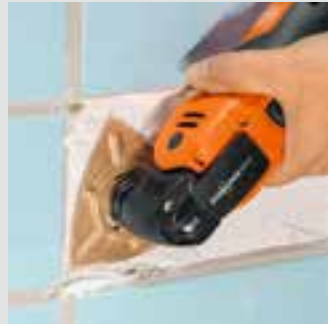
Fliesenkleber vor der Neuverfugung plan schleifen.
